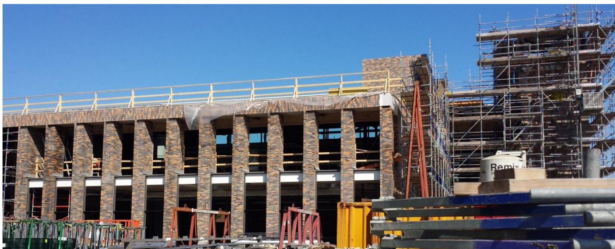
Foto Gemeentehuis Drechterland in aanbouw (bron: Rkc SED)
